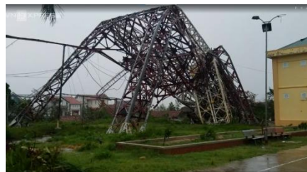
Hình 1.12: Cột tháp truyền hình thị xã Kỳ Anh gãy gập
