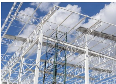
Hình 1.8: Kết cấu khung thép điển hình
